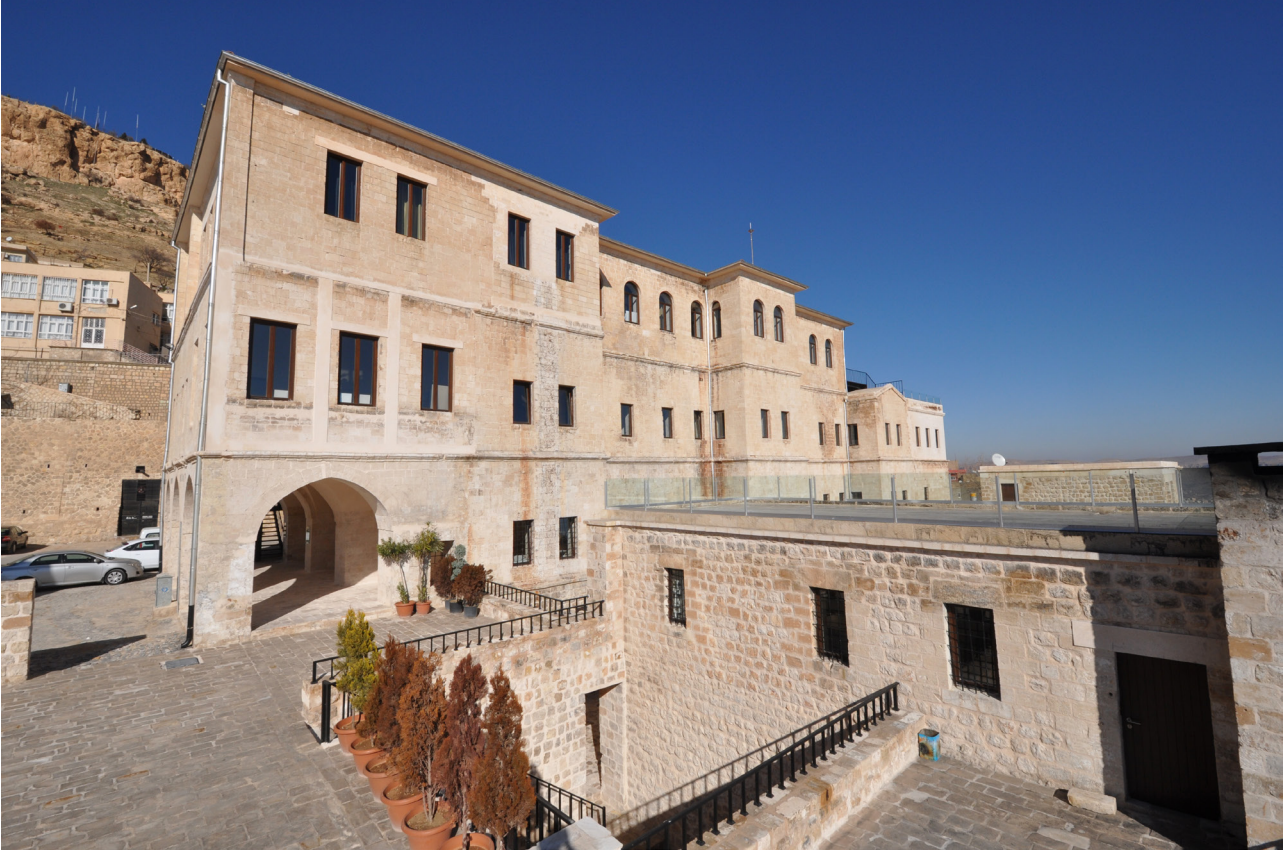
Mardin Artuklu Üniversitesi Mimarlık ve Mühendislik Fakültesi Binası
